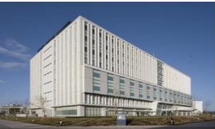
▲ 裁判所 (東京地方裁判所立川支部) ※完成から10年ほどの新しい裁判所
